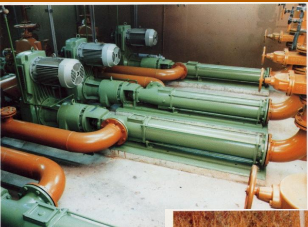
SEEPEX-Pumpen der Baugröße 200-6LBN zur Förderung von Rücklaufschlamm in der Kläranlage der Stadt Xanten.
