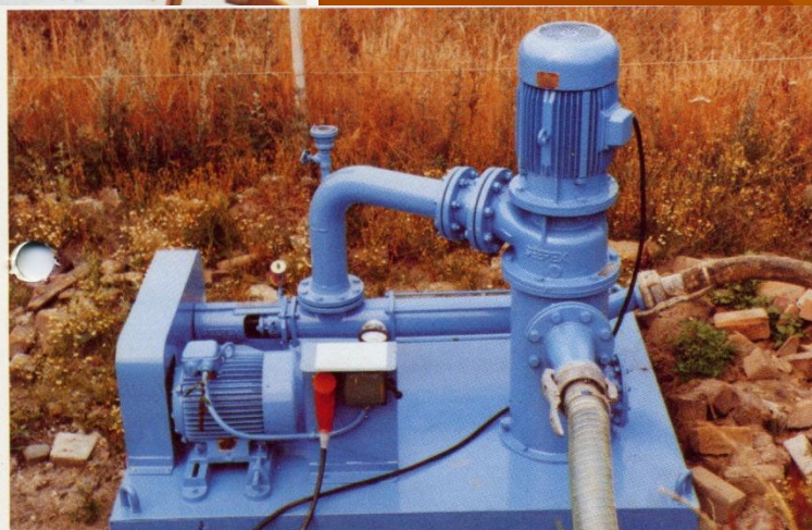
SEEPEX-Pumpen der Baugröße 200-6LBN zur Förderung von Rücklaufschlamm in der Kläranlage der Stadt Xanten.
